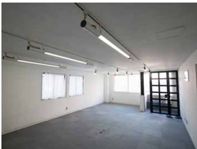
奥側から見るカフェ風カーテン窓や入り口まわり方向
