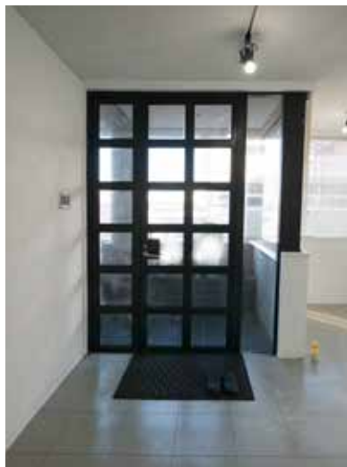
重厚なスチール(鉄)製ドアが大小あり左右見開きになります。
